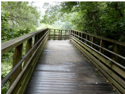
森林鉄道風歩道橋
