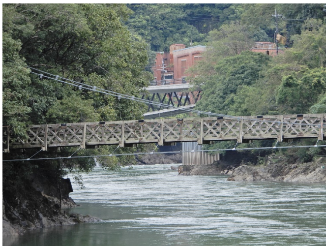
天ヶ瀬吊り橋と天ヶ瀬発電所レンガ造りの建屋
