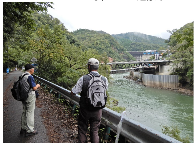
白虹橋(景観上特殊な構造)とバックに天ヶ瀬ダム
