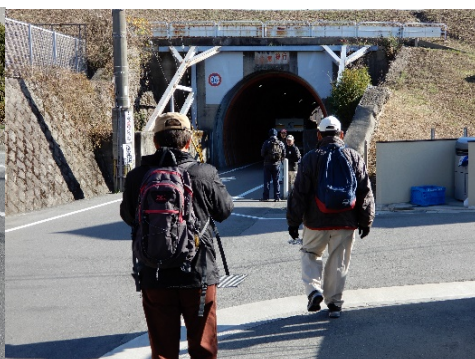
摂津鉄道跡天神川トンネル
